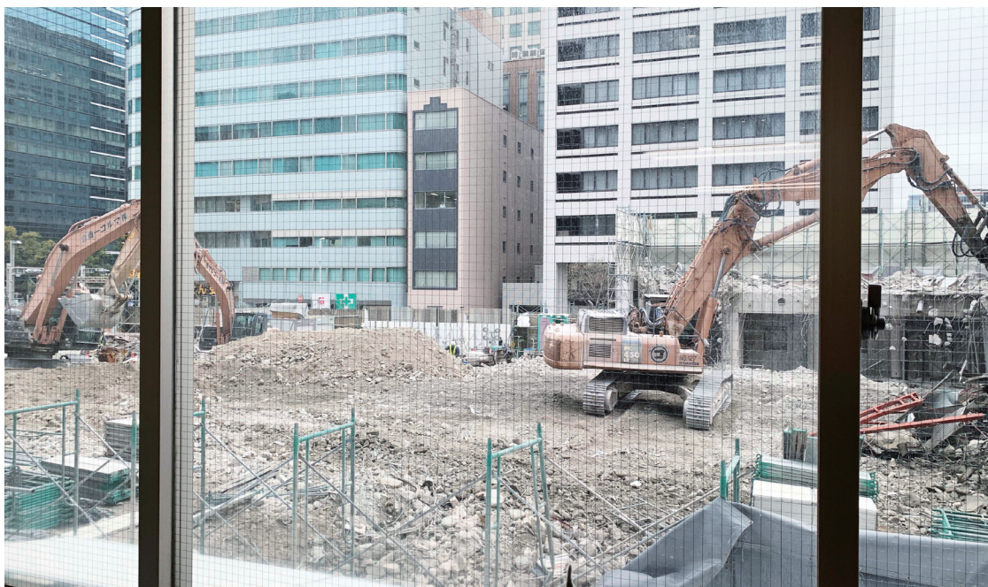
名古屋YWCAビル2階ロビーから
